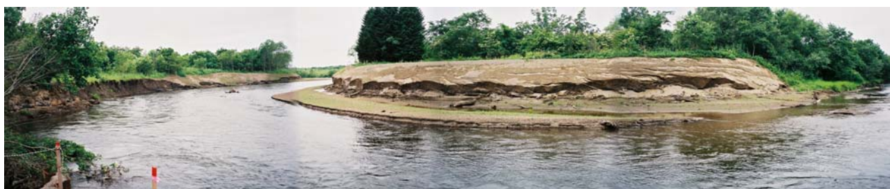
図 - 15.1.9 蛇行河道：局頂部内岸側および外岸側の河岸浸食状況（平成 14 年 7 月：大規模洪水前）
