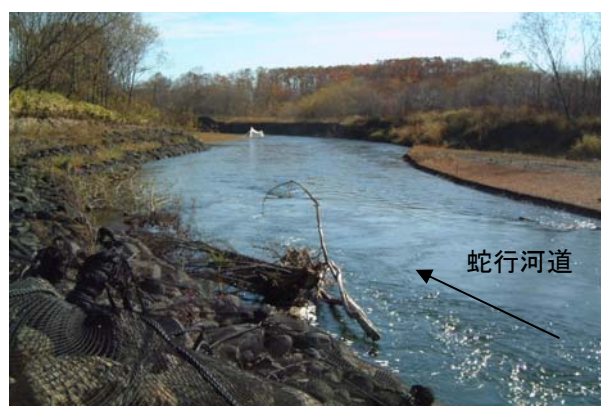
図 - 15.1.12 護岸設置状況（H14.11）
