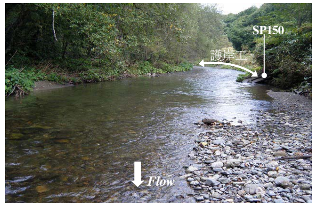
写真-7 護岸区間（巨礫設置試験区）の様子
