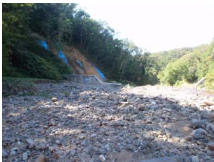
a) 改良前（上流より撮影）
