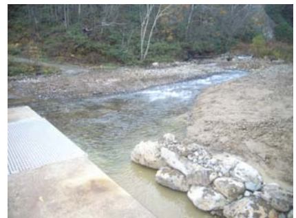
c) 改良後（魚道流入口付近）
