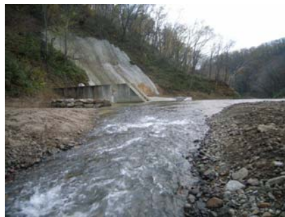
b) 改良後（上流より撮影）
