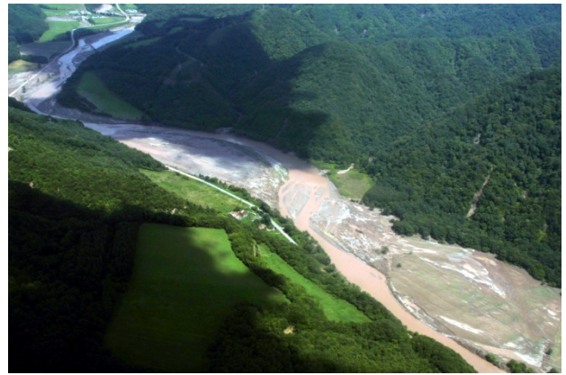
図-15.5.23 2003年出水時の厚別川での流況
