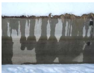
写真-5 南面における冬期間の水路側壁 (セメント系補修区間)
