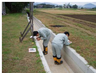
写真-7 現地調査状況
