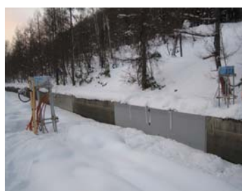
写真-3 試験施工区間における冬期の観測状況
