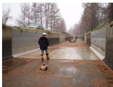
写真-4 落水後の目視調査状況
