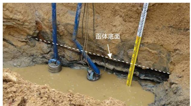
写真-14 函体下の空洞
