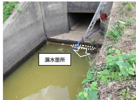
写真-13 函体下の漏水状況
