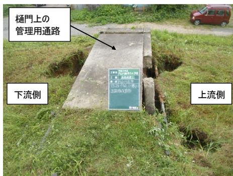
写真-12 陥没状況
