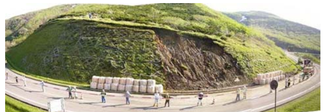
写真－６ 第四紀火山噴出物からなる切土のり面の崩壊事例（管轄事務所提供）
