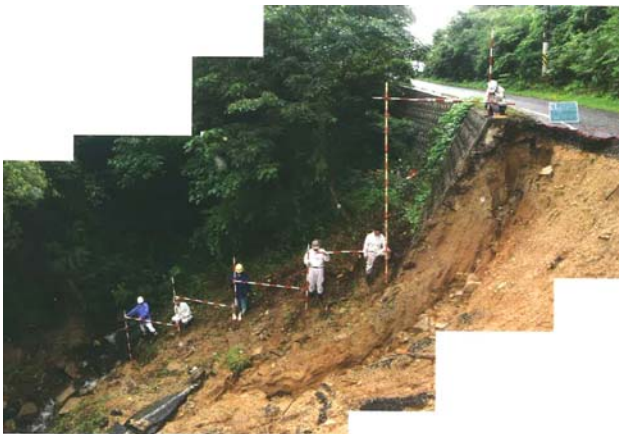
(a) 災害後（管轄事務所提供）
