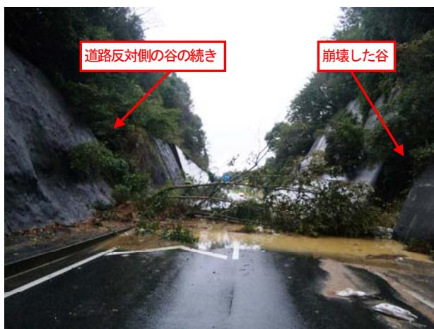
(b) 道路に流出した土砂および倒木 写真－５ 小規模な谷地形の崩壊事例 (管轄事務所提供)
