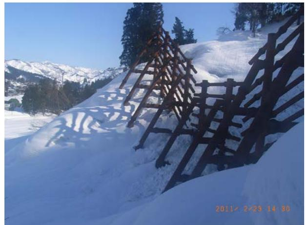
図 9 減勢工への雪崩衝突の様子（魚沼市湯之谷地区、上：2月23日14時、下：2月23日14時30分）
