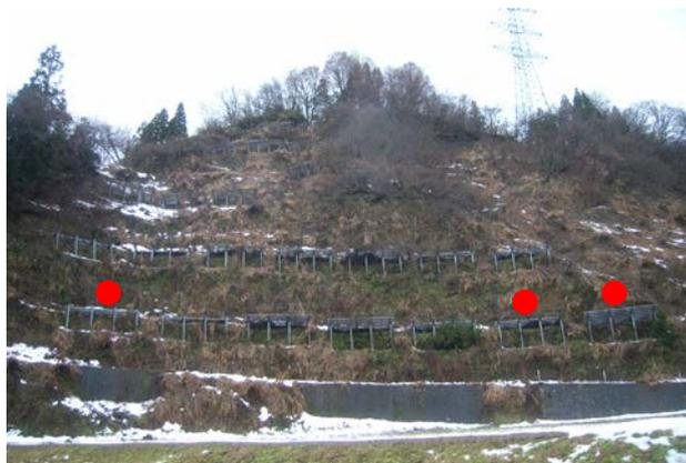
図 2 横バーをはずした予防柵（●印はもみがらの充填箇所）
