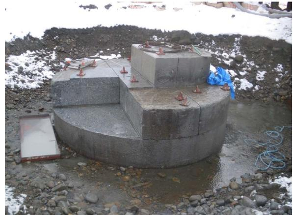
写真-4 RC 橋脚の撤去状況
