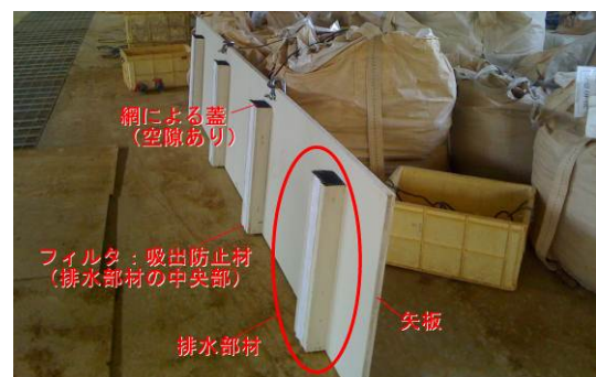
図-3.12 ケース4の透水トレンチの設置状況
