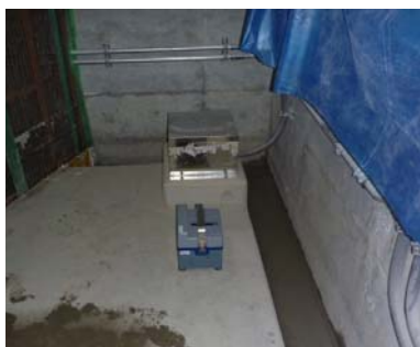
図-3.3.7 監査廊内での計測状況
