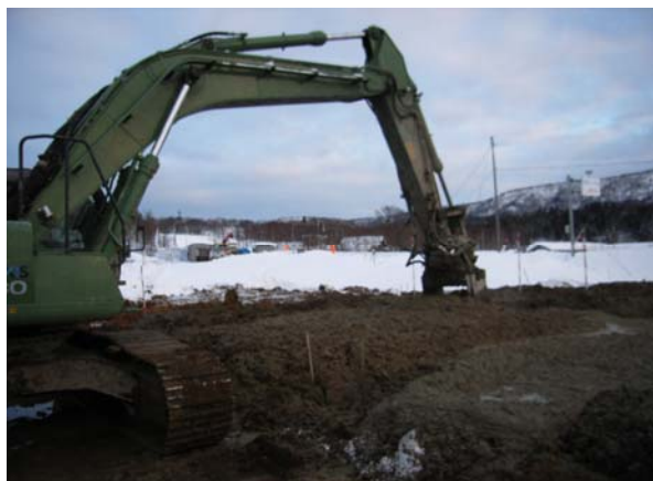
図5 冬期施工の様子
