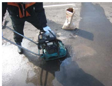
写真-3 擬似ポットホールの常温混合物 転圧状況
