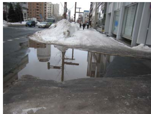
写真-1 厳冬期における路面状況 (一般国道 230 号札幌市)
