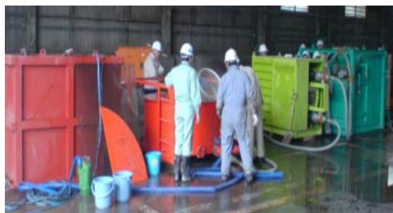
写真3 気泡混合土の製造プラント
