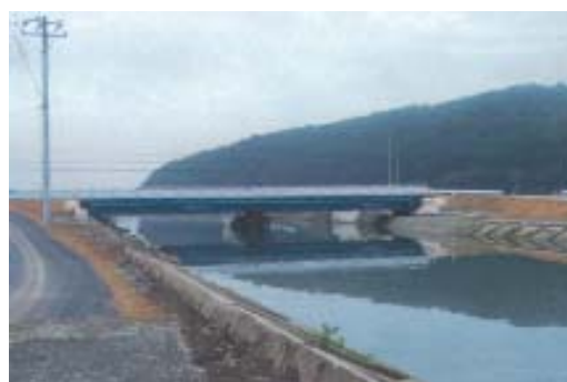
写真1 気泡混合土施工箇所の事例 (国道398号 宮城県南三陸町戸倉)
