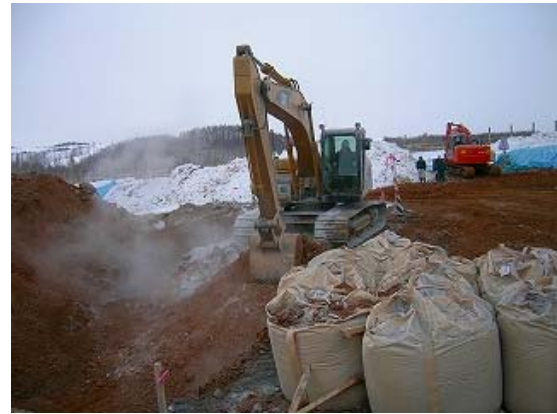
写真-3 冬期の固化材による改良
