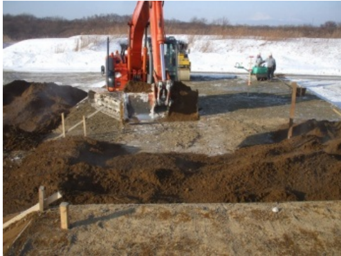
写真-2 試験施工状況
