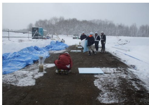
写真-1 砂置換による盛土の密度測定
