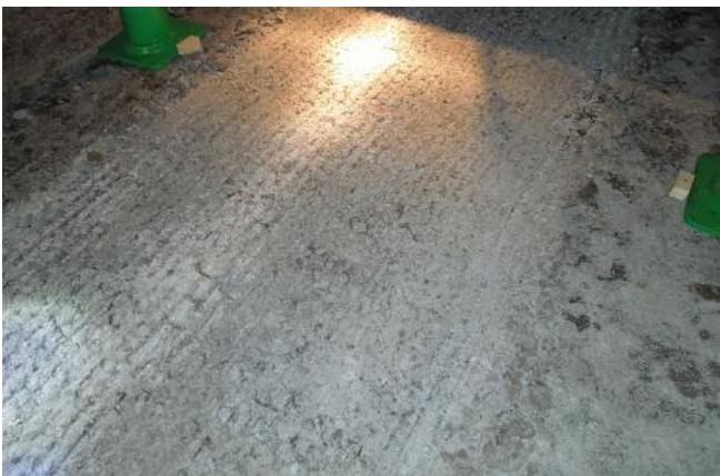
写真-11 後方排雪装置の併用施工 (路面へ追従した場合)
