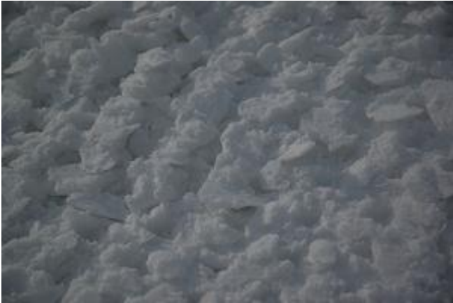
写真-10 氷板・圧雪路面処理装置のみによる施工 (破砕雪の大きさは5cm×5cm程度)
