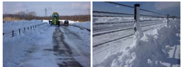
写真10 除雪試験と除雪作業後の堆雪状況
