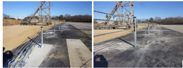
写真4 防護柵設置状況
