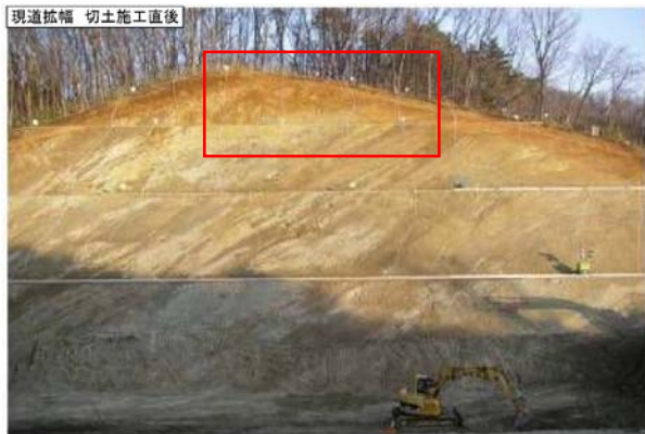
写真-3 上記のり面の施工中の写真（管轄事務所提供）
