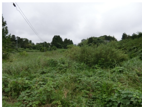
写真15 変状の大きい箇所の法尻部の状況（破線は道路面位置）
