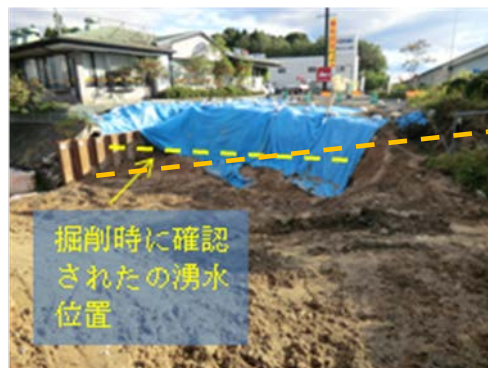
写真11 掘削時の湧水位置
