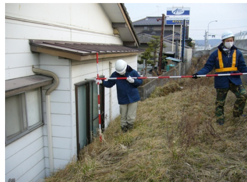
写真26 民家と土砂の状況（事務所提供）
