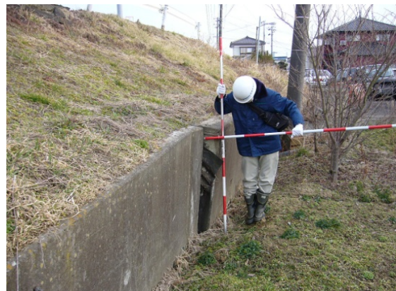
写真28 擁壁の変状
