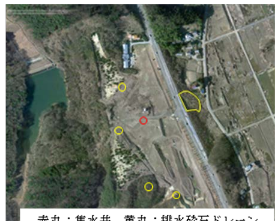
赤丸：集水井、黄丸：排水碎石ドレーン 写真 3 被災後（撮影：Google）
