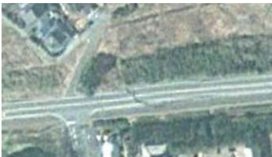
写真13 被災直後の航空写真（撮影：Google）
