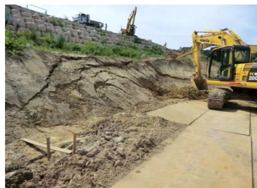
写真 4 復旧中ののり尻部の状況
