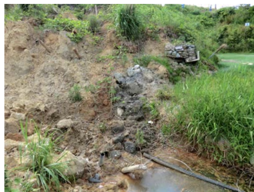
写真22 のり尻部の排水対策と湿潤状況
