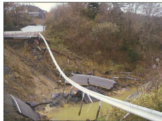
写真7 崩壊箇所の状況（事務所提供）
