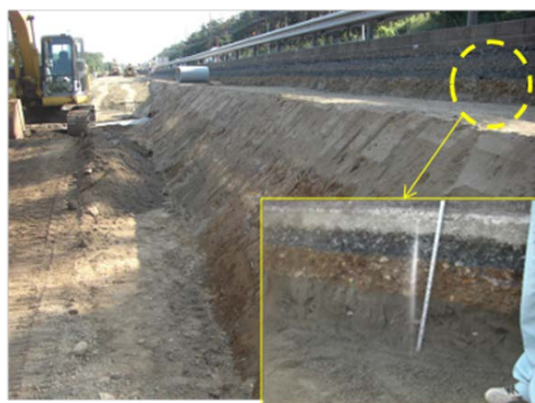
写真32 道路中央部の断面状況
