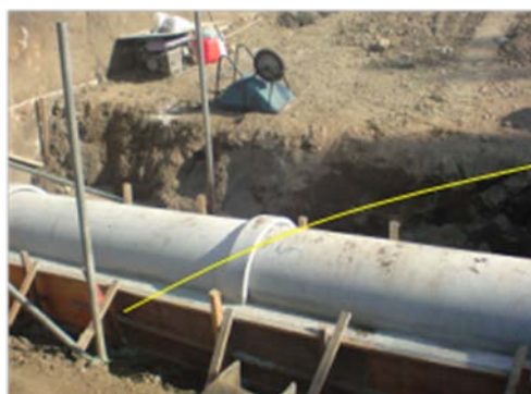
写真33 道路横断面の状況
