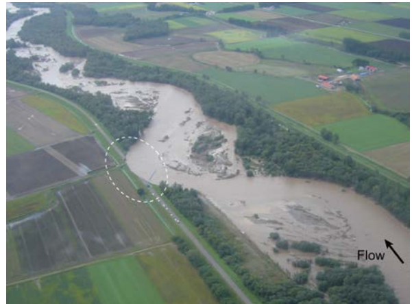
図-3 堤防流出状況（9月7日午前）
