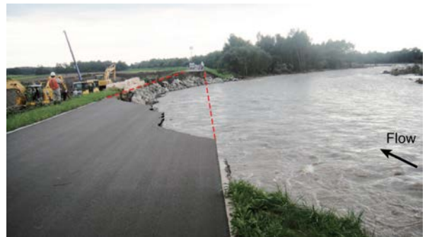
図-4 応急対策後の現地状況（9月9日15:30）
