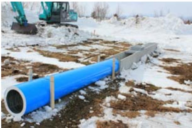
写真-2 トラフ及びダクト設置
