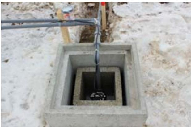
写真-4 採水柵及びフィルター設置
