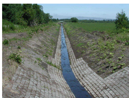
写真-1 連節ブロック型排水路
