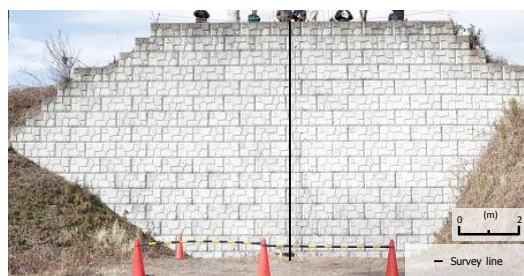
写真-5 補強土壁①
