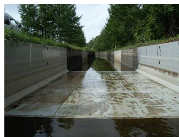
図-45 施工後の状況（灌漑期間1回終了時）
