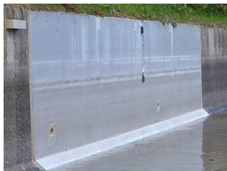
図-51 FRPM 板の施工 6 年後の状況（南面）
