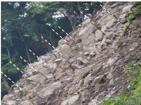
(b) 受け盤状の開口節理(白点線)
