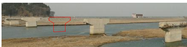
写真-1 津波により橋桁が流出した橋梁
