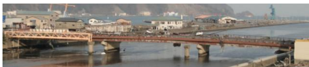
写真-1 津波により橋桁が流出した橋梁
