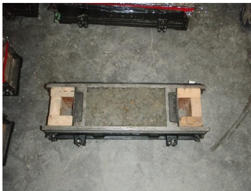
写真-5 角柱供試体 (□150×L300) 作製状況
