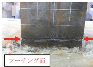
写真4.1 H形鋼基部の腐食欠損状況
