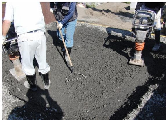
写真-2.2 砕石緩衝材の転圧状況 (G70-2 層目)
