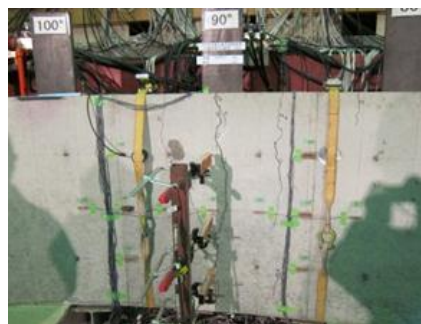
天端（90度）付近の覆工内面の状況
