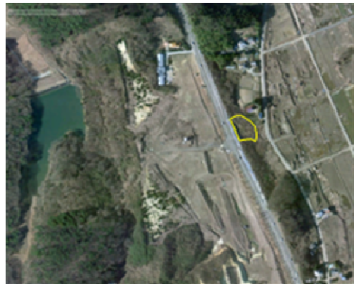
写真3 崩壊後の航空写真 (2011年4月 Google Earth)
