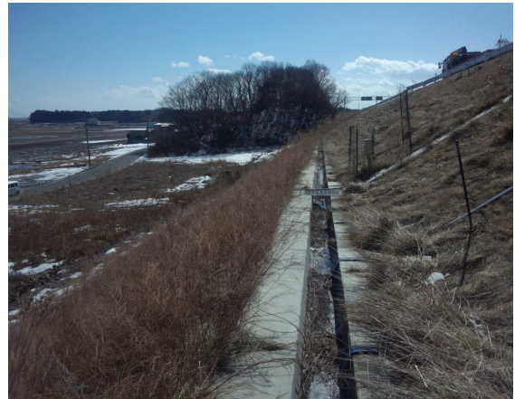
写真5 盛土のり面および周辺の状況
