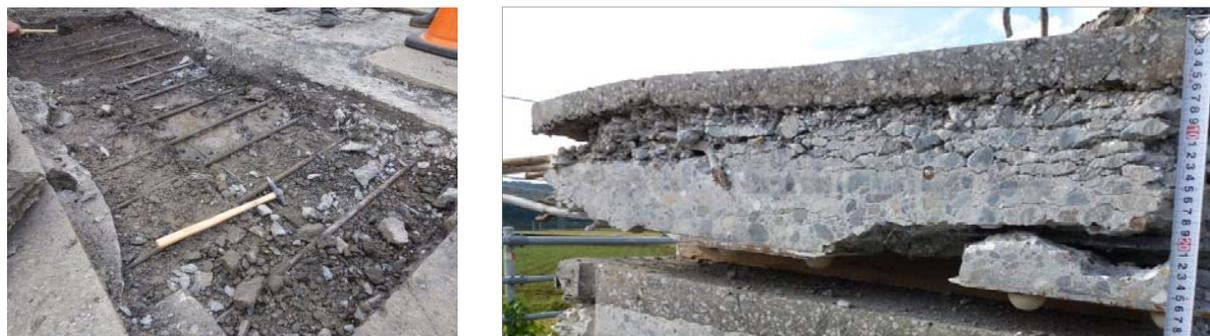
写真-1 床版損傷 (左; 上面劣化損傷、右; 内部劣化損傷)
