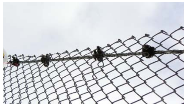
写真-2.2 ワイヤロープの固定状況
