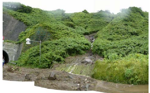
写真-13 土石流事例 (図-11 ③の事例)
