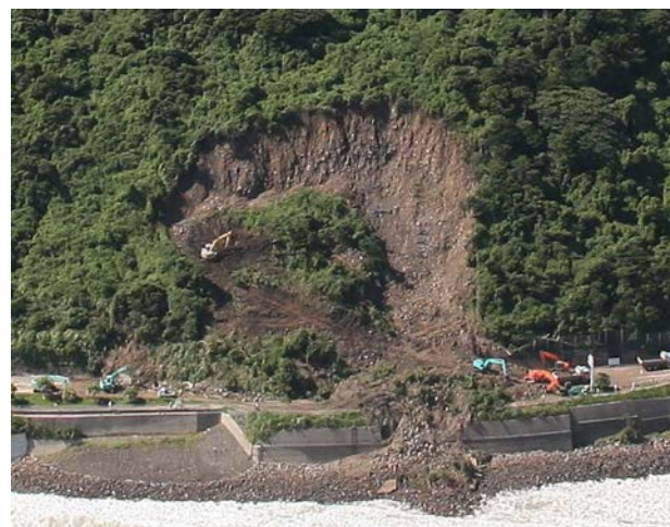
写真-10 地すべり事例 (図-10 の事例)
