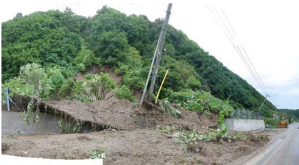
写真-4 自然斜面崩壊事例 (図-7 ①の事例 2回目の崩壊)
