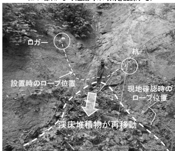
図-4.3 土砂移動時刻ロガー設置箇所の土砂移動状況
