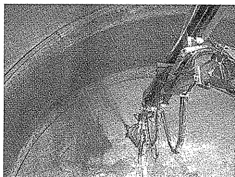
写真-4 ダストレス吹付け機による試験状況
