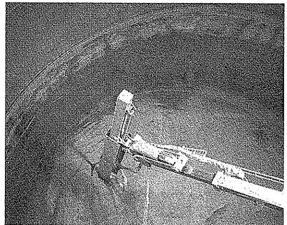
写真-3 液体急結剤による試験状況
