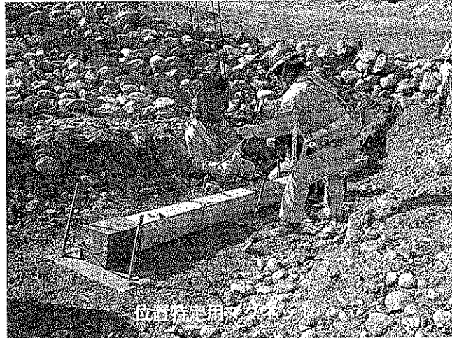
写真-1 フィルダムリップラップ内に設置中の測定管
