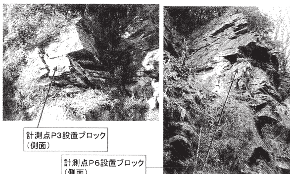
写真-5 計測点P3及びP6設置ブロック側面
