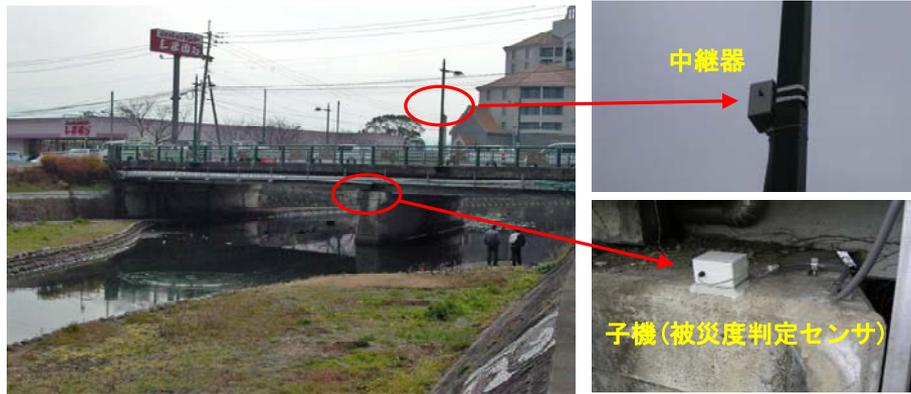
図-21 被災度判定システムの実橋梁への設置
