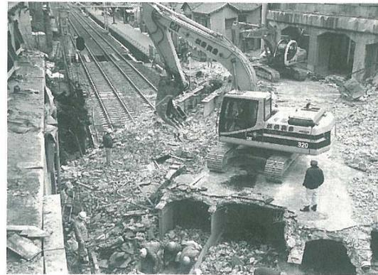
(d) シナリオ D：上部構造が橋軸直角方向へ大変位した例<sup>12),13)</sup>
