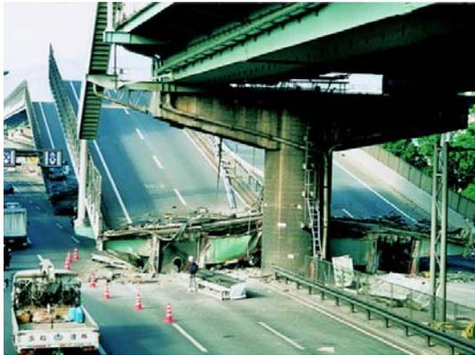
(c) シナリオ C：上部構造が橋軸方向へ大変位した例<sup>14)</sup>
