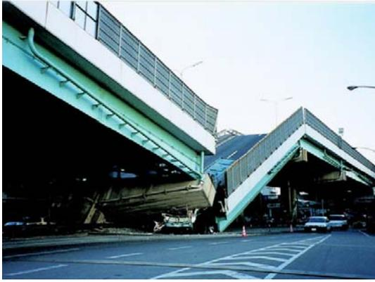
(a) シナリオ A：下部構造が倒壊した例<sup>14)</sup>
