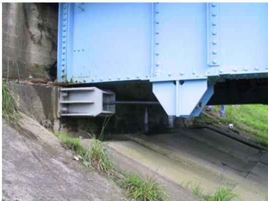
図-2 落橋防止構造が機能した例<sup>19),20)</sup>
