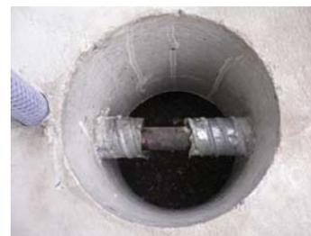
図-15 PC鋼棒切断用の円形孔
