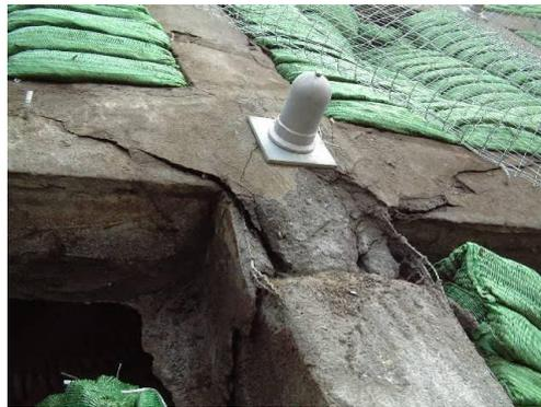
写真-2 地山補強土工の被害事例<sup>1)</sup>
