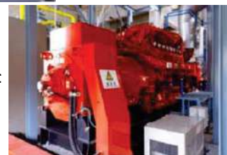
横浜市北部汚泥資源化センターの卵形消化タンク（上）と消化ガス発電機（下）
