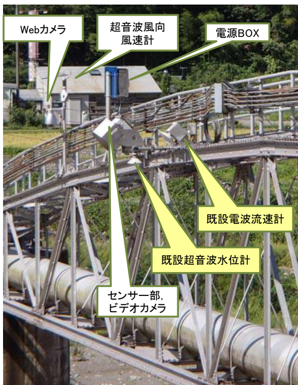
右岸(局舎近く)から撮影
