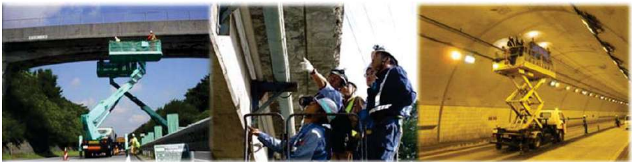
近接目視点検
