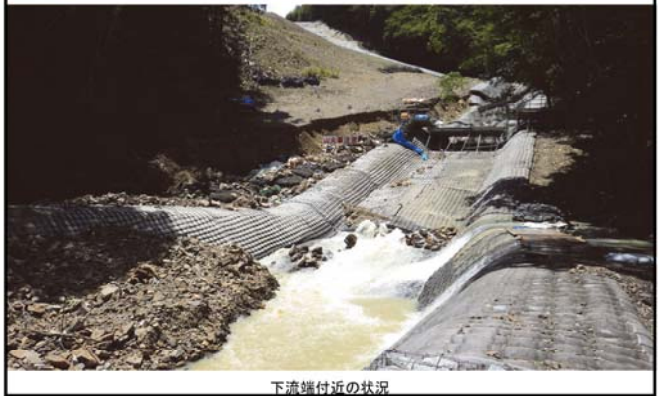
下流端付近の状況
