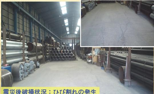
震災後破損状況：ひび割れの発生
