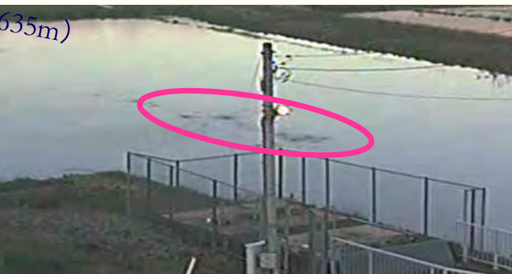
漏水湧出卓越範囲 (10/6の日没直前の監視カメラ画像)
