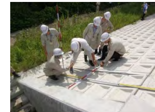
沈下・陥没の確認
