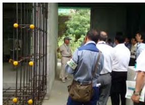
ボックスカルバートの講習
