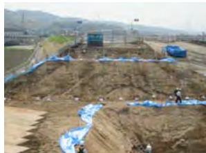
堤防開削時土質調査状況
