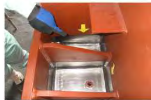
チタン箱施工状況
