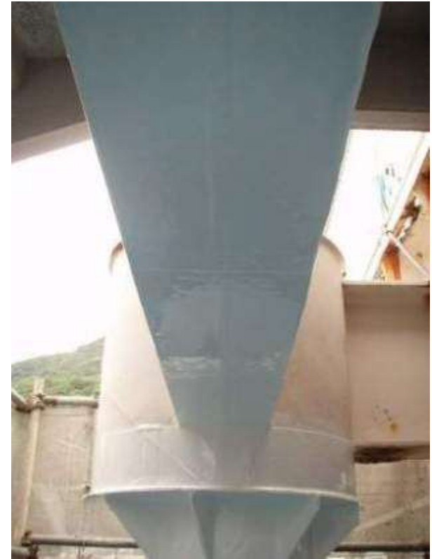
チタン箔＋重防食塗装の塗装系(Rc-Ⅱ塗装系参照)
