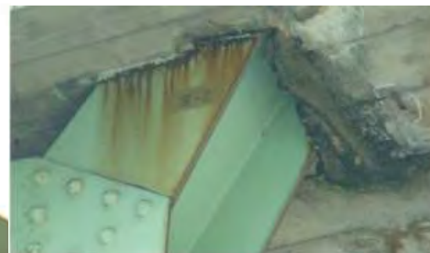
コンクリート埋設部
