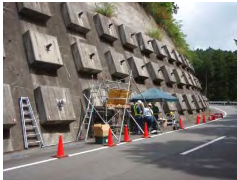
施工後に設置
