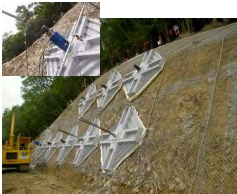
施工時に設置
